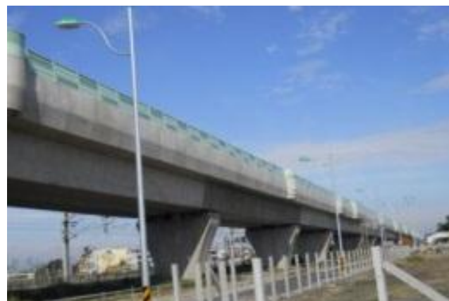
鐵路局YCL-121 員林高架橋工程 地點:台鐵里程 K227+810~230+059, K230+646~K231+860
