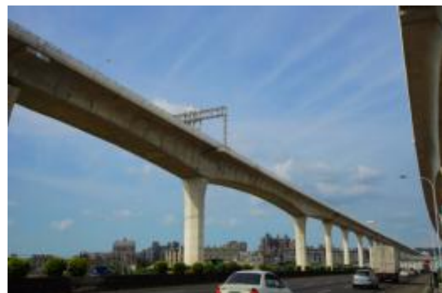
國道1號五股楊梅段 拓寬工程C906標 地點:國道1號南下線 45K+000~50K+970
