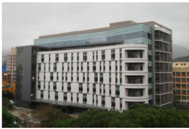
中央研究院 跨領域科技研究大樓 台北市南港區研究院路2段128號
