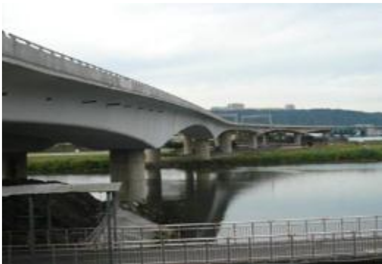
新北市特二號道路第3-1標 新莊中正路至板橋大漢溪橋縣民大道
